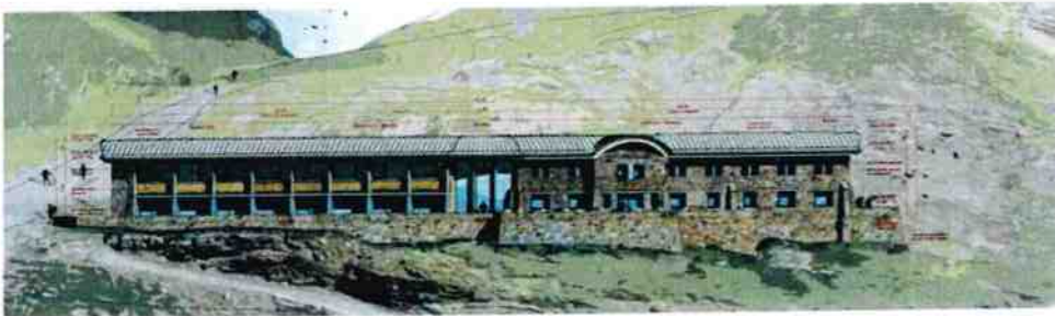
Vue de la façade sud – Après projet
